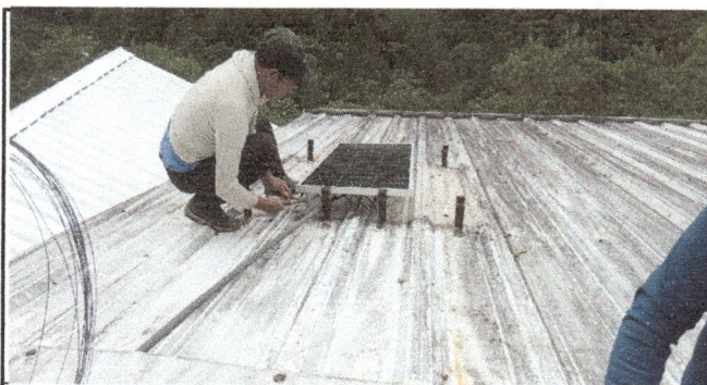
Foto 6: instalación de paneles solares.
