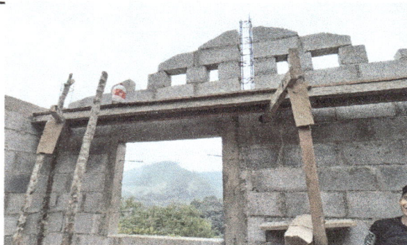
Foto 3: se observa la terminación de los trabajos de habilitación de paredes.
