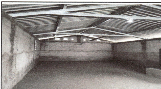
Foto 4: se observa la losa de piso.
