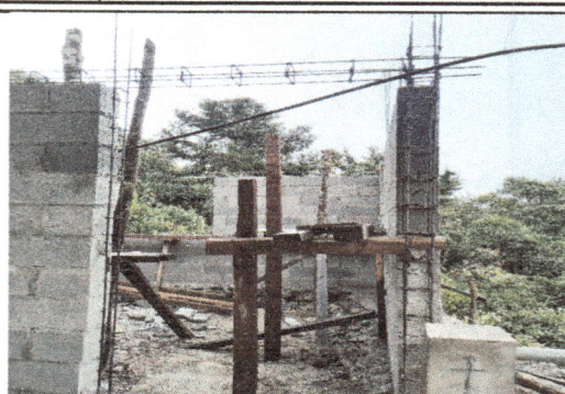
Foto 2: aca se observa el avance de los trabajos de la cocina
