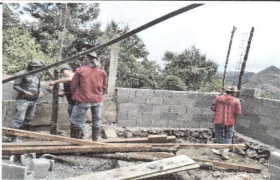
Foto 1: aca se visualiza los trabajos de habilitación de paredes
